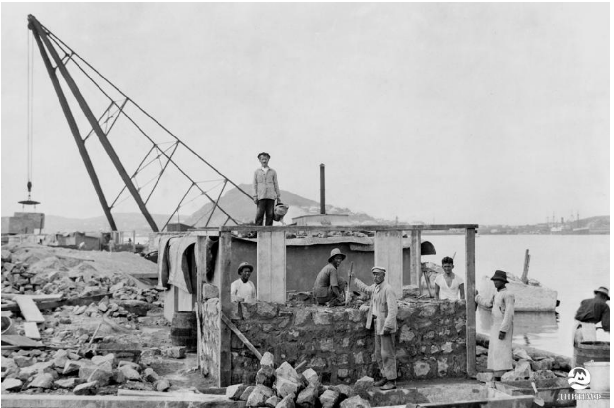
Владивосток, 1915 г. Строительство причала № 50 на мысе Чуркина
