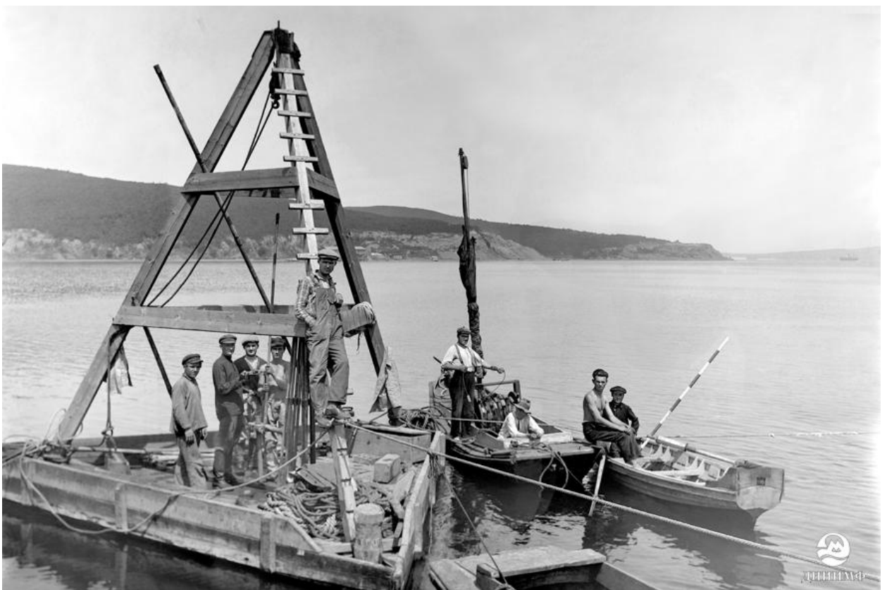
Владивосток, 1932 г. Буровая установка в бухте Диомид
