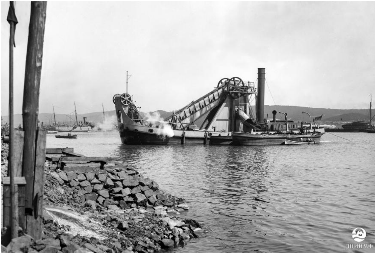
Владивосток, 1927 г. Землечерпалка работает на дноуглублении в районе мыса Эгершельда
