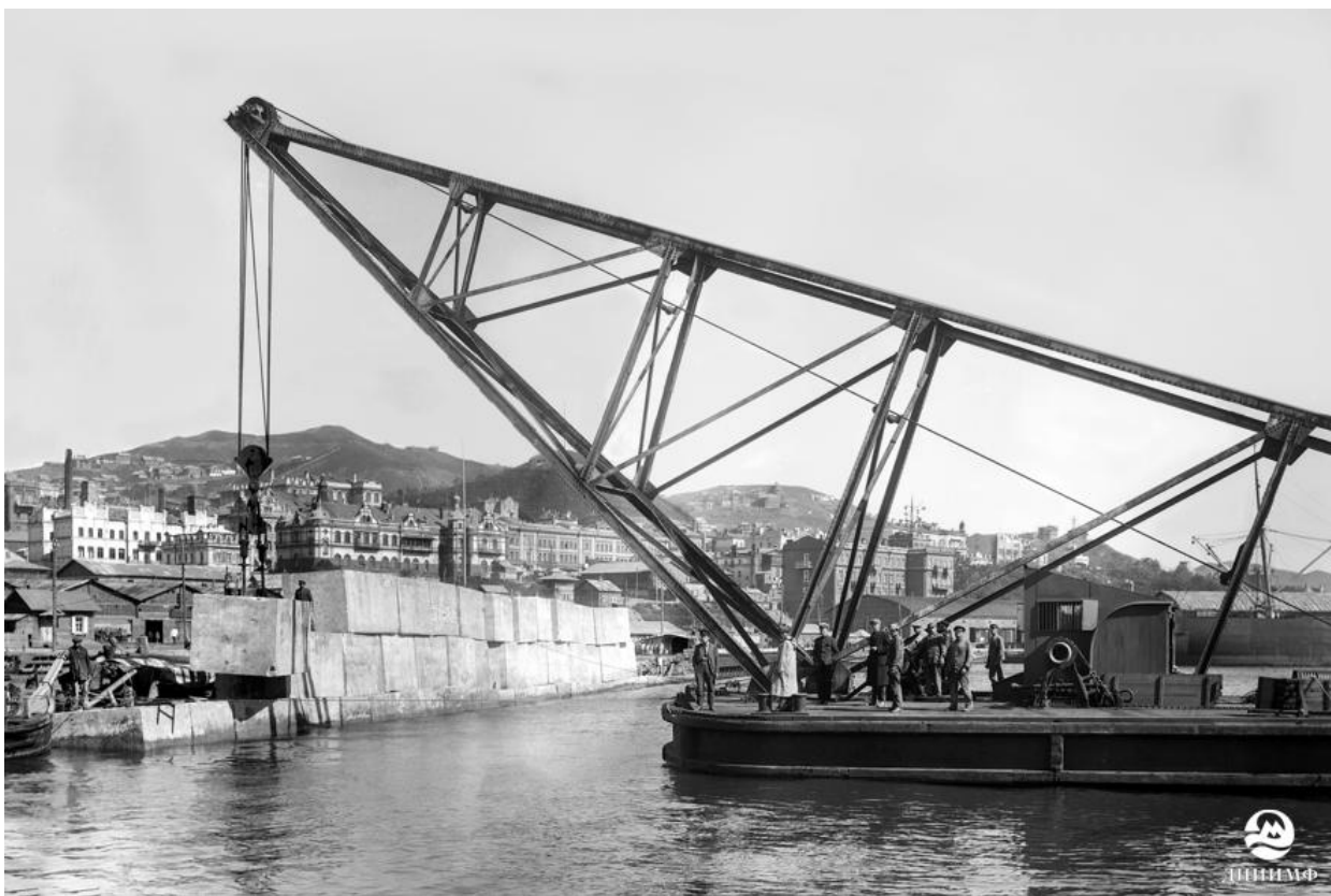
Владивосток, 1924 г. Строительство набережной причала № 30
