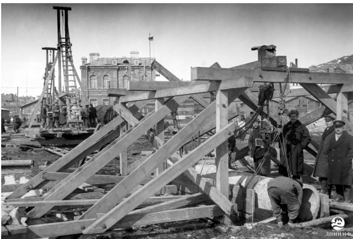
Владивосток, 1924 г. Инженеры УПИТО следят за укладкой выпускной трубы на причале № 30
